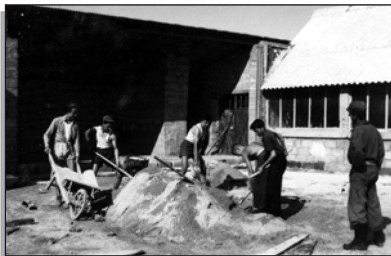
La tâche des apprentis maçons consiste en la fabrication, le transport et la mise en place de parpaings en agglomérés (collection M. RENAULD).
