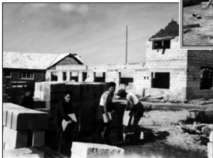
La tâche des apprentis maçons consiste en la fabrication, le transport et la mise en place de parpaings en agglomérés (collection M. RENAULD).
