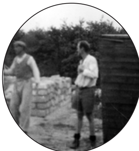
A droite sur le cliché, en tenue de travail, l'abbé DUVALLET, responsable du chantier de Conflans-Sainte-Honorine (collection J.-F. BERNARD).
