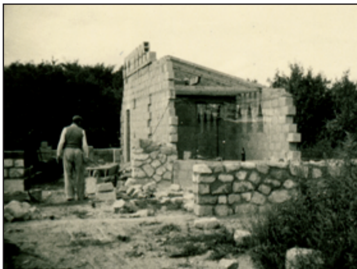
A l'heure du départ, la chapelle de la Cité de l'Espérance est encore en cours de construction (collection J.-F. BERNARD).
