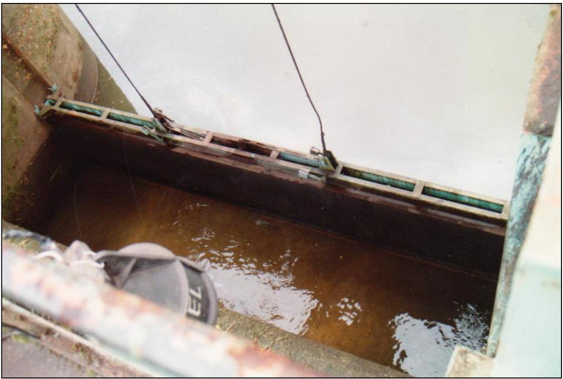
Mécanisme de retenue du barrage de Beth vu depuis la passerelle surmontant l'ouvrage. En 1993, alors que la *"Nouvelle Division"* des hauts fourneaux est définitivement arrêtée, un incident exceptionnel et imprévu, un arbre déraciné bloquant ce mécanisme du barrage, entraîne une montée anormale du niveau des eaux en amont. L'intervention sur l'ouvrage permet un retour rapide à la normale, et des mesures sont prises afin qu'un incident semblable ne puisse plus se reproduire.
