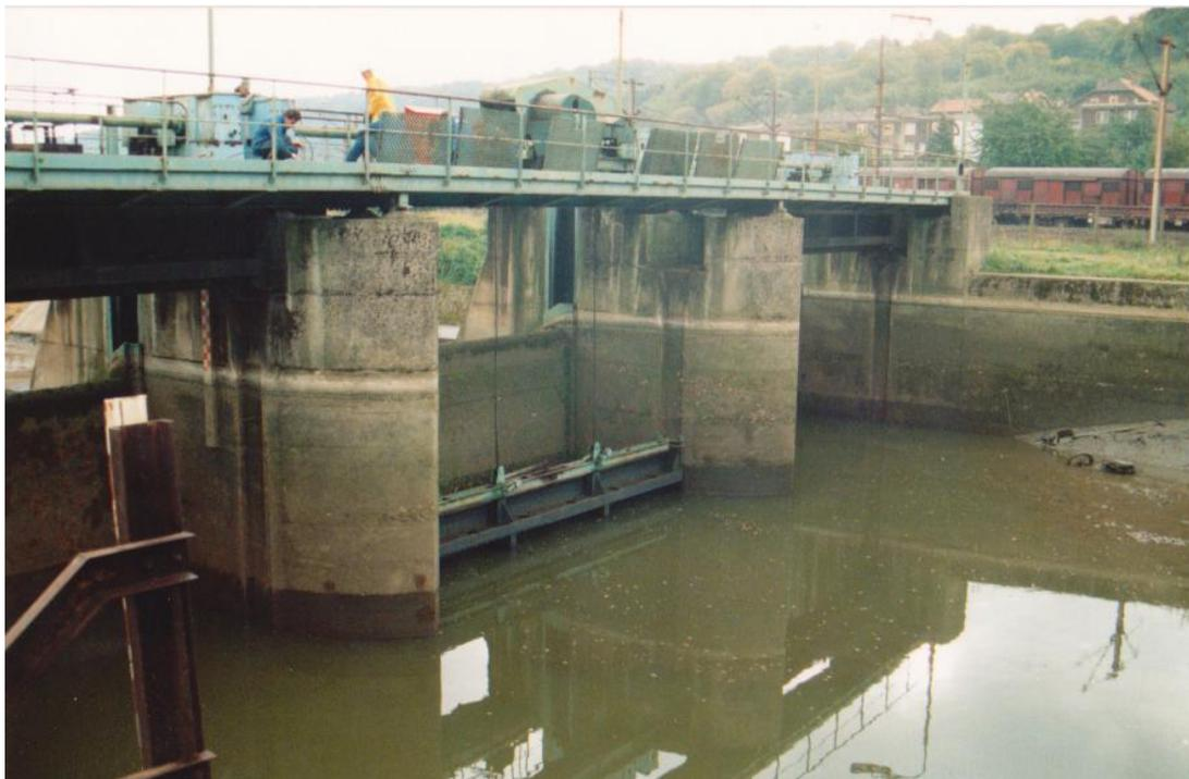
Vue du barrage de Beth en amont, en situation de basses eaux. Pendant les travaux, avec le barrage ouvert, une station de pompage provisoire aménagée en aval derrière des bardeaux par l'entreprise Richert de Metz-Borny assure la fourniture de 5000 m<sup>3</sup>/ heure nécessaires au refroidissement des hauts fourneaux J1 et J2.
