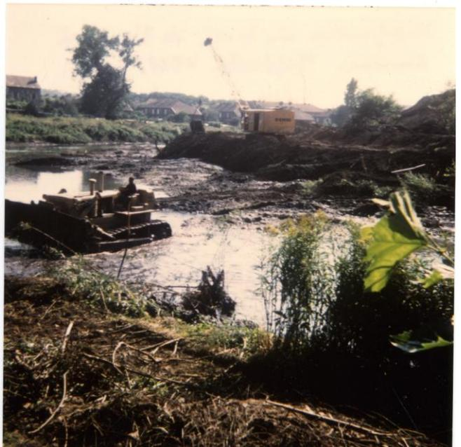
À partir du coude de la rivière où se trouvait le bief du moulin de Ravenne, les draguelines peuvent travailler à partir de la rive gauche. En arrière-plan sur la gauche, on aperçoit les maisons du quartier Mangin et de la rue de Ravenne ; derrière l'engin se détache la masse imposante du crassier haut de 10 à 15 mètres selon les endroits.
