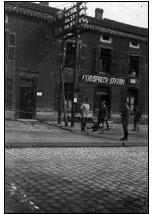
La station téléphonique allemande au cœur de Franchepré. Sur cette partie droite de la chaussée, les pavés demeurent en bon état.
