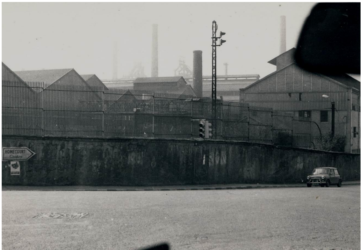
Derrière le mur de l'usine d'Homécourt surmonté de hautes grilles, les halles des laminoirs demi-produits (au premier plan les fours Pitts, puis le Blooming). En arrière-plan dans le lointain, une partie de l'alignement des hauts fourneaux.
