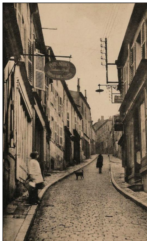
Vues de la Grand' Rue, au cours des années vingt et trente. À gauche, le réseau électrique est établi avec des potelets métalliques scellés dans les façades des immeubles ; à droite, un exemple des premières lampes qui ont remplacé les anciens réverbères et qui équipent désormais les rues briotines.
