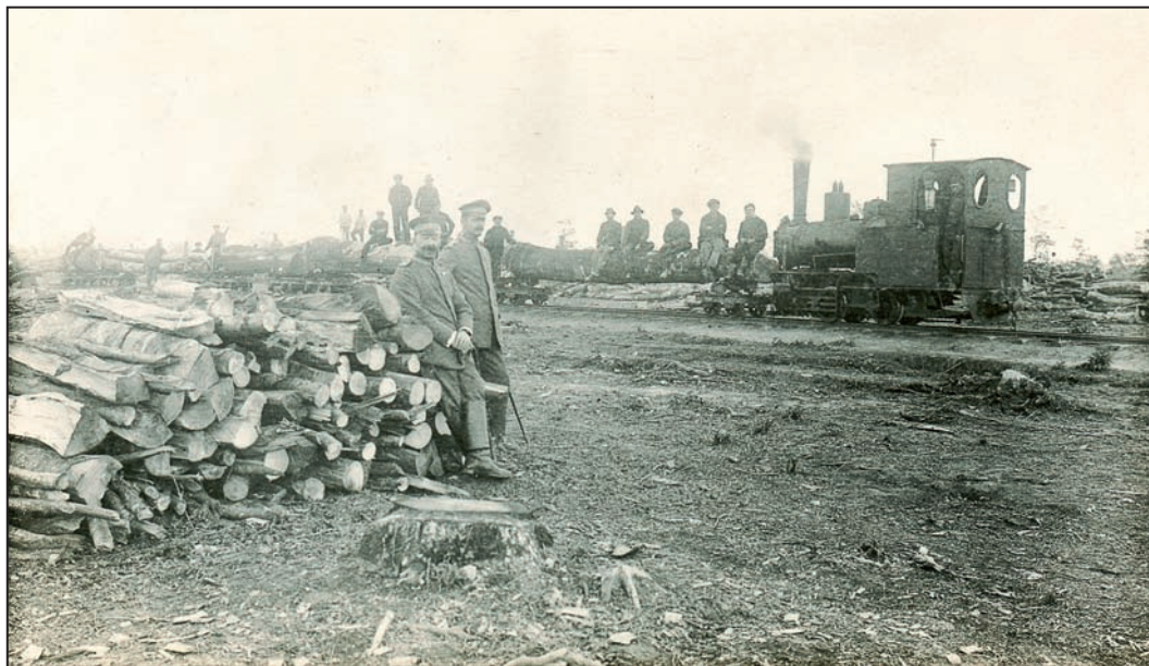
“ Transport der Baumstämme ” – Transport des grumes. La Kommandantur du camp et les civils belges posent avec un convoi de grumes, placés sur des bogies ou des wagons et prêts à être acheminés jusqu’aux scieries de la vallée (collection R. Martinois).
