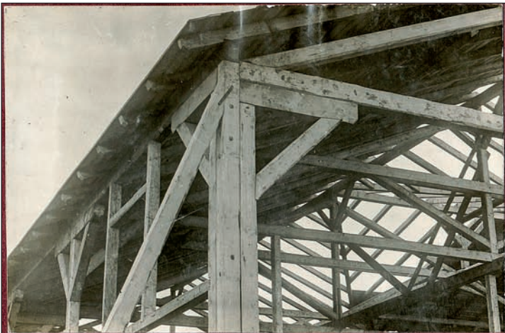
Bau eines Flugzeugschuppens für eine Bayr. Fliegerstaffel bei Briey
