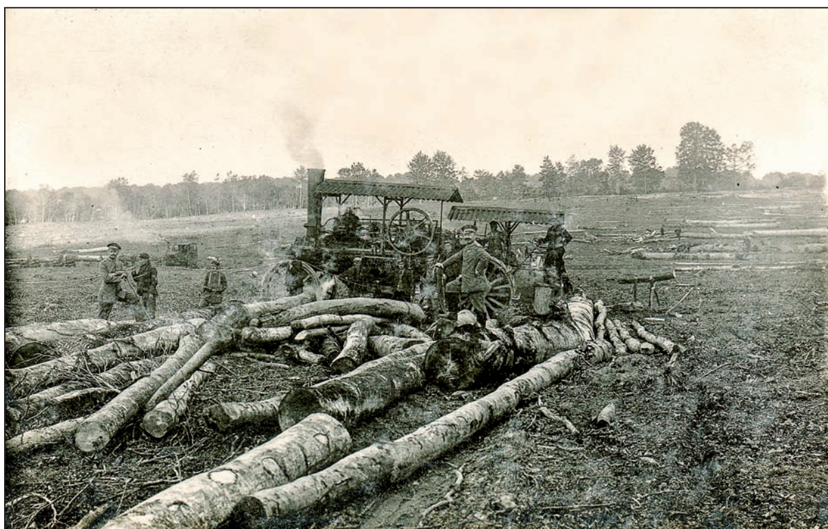
“Heranziehen der Baumstamme” – Rassemblement des troncs d’arbres (collection R. Martinois). Une fois abattus et ébranchés, les troncs sont rassemblés à l’aide d’une locomobile utilisée comme tracteur. Canne à la main et juché sur l’une des grumes, le lieutenant RAU prend une pose martiale digne de figurer en bonne place dans son album.
