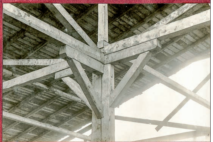
Knotenpunkte der Holzkonstruktion
