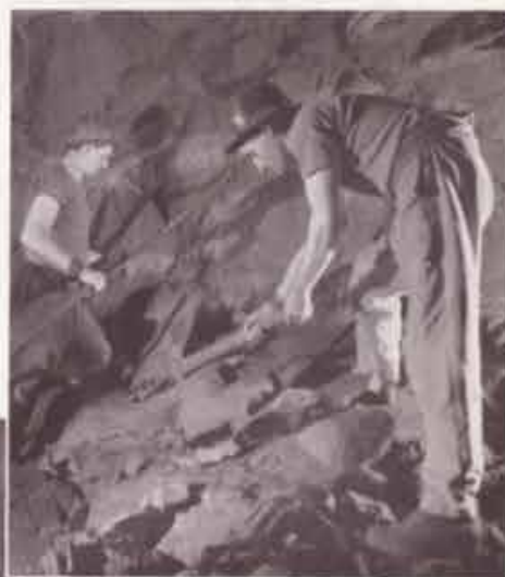
Forage d'un trou de mine.
