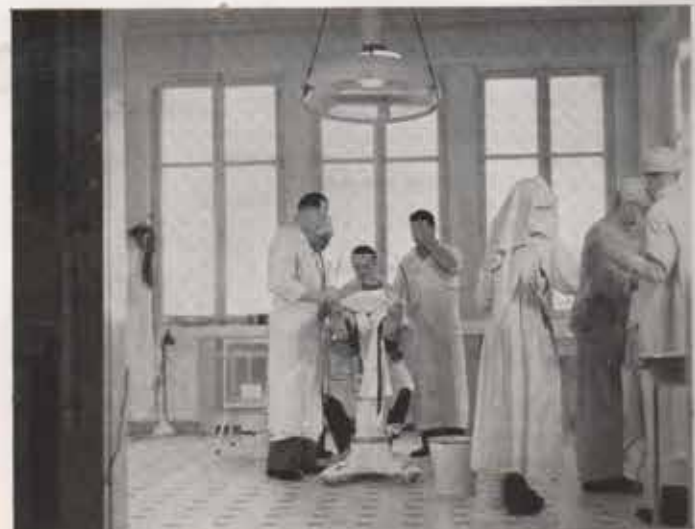
Salle d'opération d'un hôpital.
