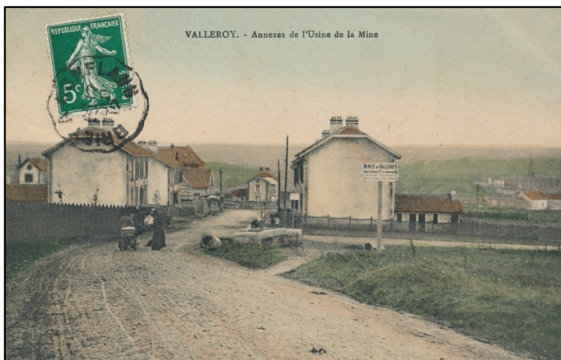
Vue des cités édifiées par la Mine de Valleroy en arrivant du village primitif.
