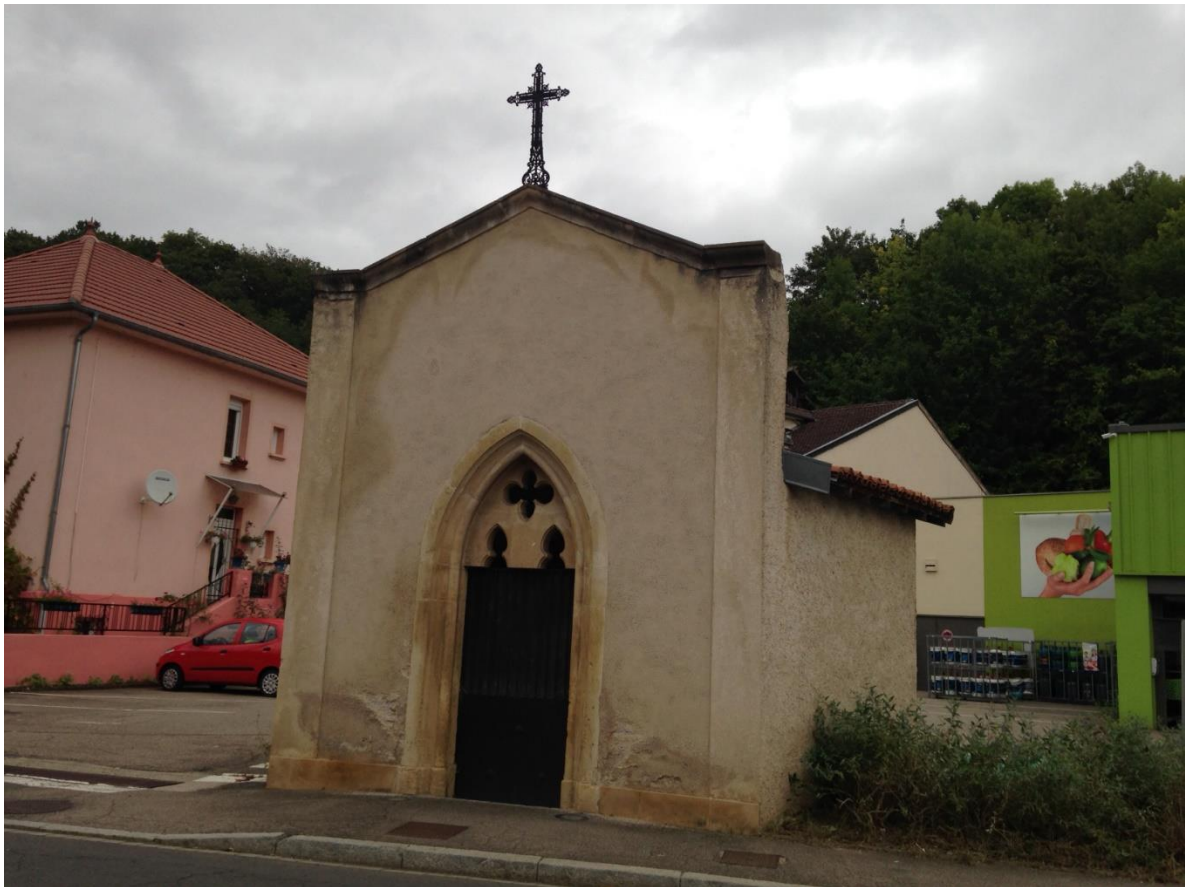
Vue actuelle de l'oratoire St-Antoine, en bordure de la rue de Metz (cliché septembre 2017).
