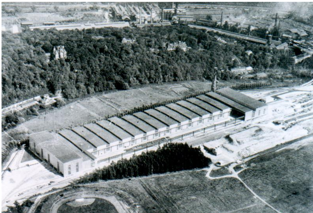
Bâtiment du train-fil en 1956.
