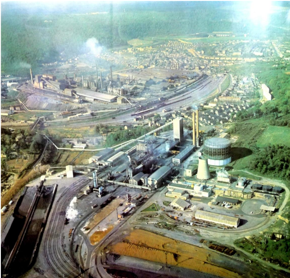
Vue aérienne de la cokerie et de l'usine d'Homécourt (photo vers 1963/64).
